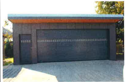
Tor-Optik und Fassadenverkleidung der Garage sind perfekt aufeinander abgestimmt
