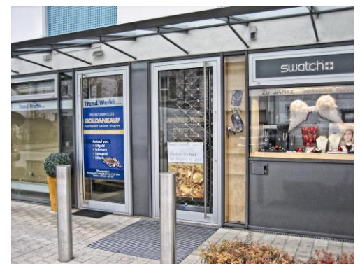
Einfach und sicher: handbetätigtes Rollgitter für Eingangstüren
