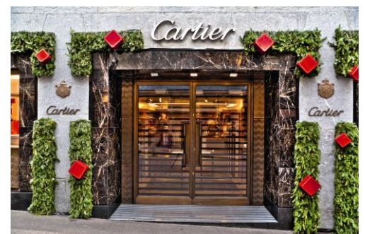
Transparenter und trotzdem geschützter Eingangsbereich
