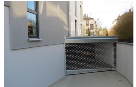
Tiefgaragen-Rollgitter MRTG plus als zweiter Rettungsweg
