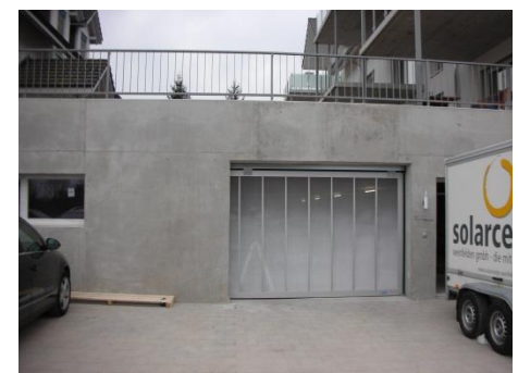
Tiefgaragen-Schiebetor MSSTG plus als zweiter Rettungsweg
