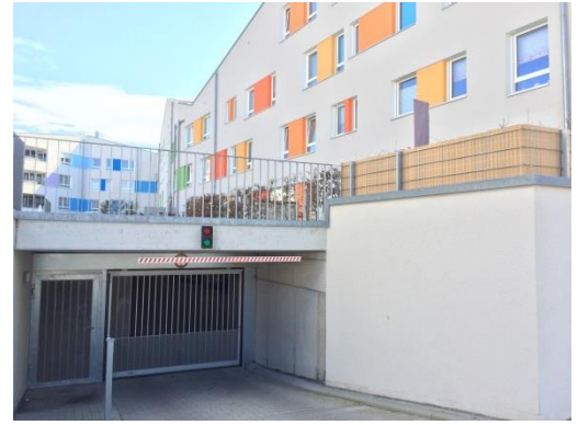
Tiefgaragen-Kipptor in großer Wohnanlage
